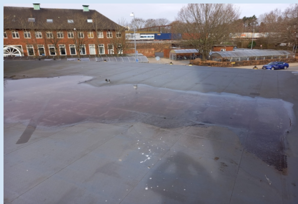
Uhensigtsmæssig opbygning af fald bevirker, at der står vand på tagfladen
