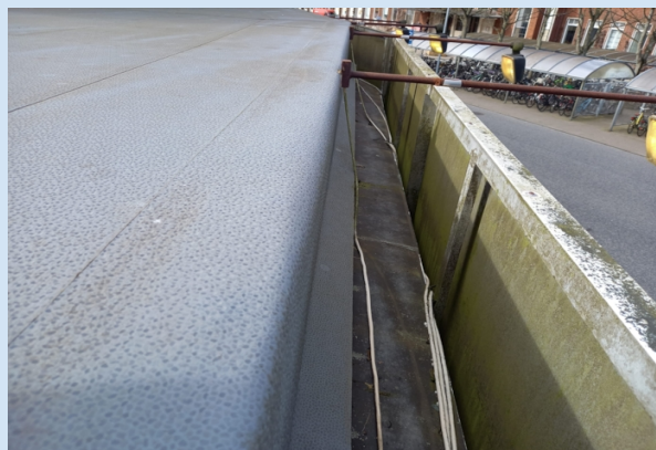
Uhensigtsmæssig opbygning af fald bevirker, at der står vand på tagfladen
